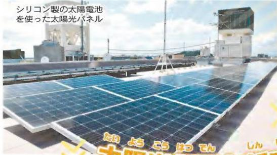
シリコン製の太陽電池を使った太陽光パネル
