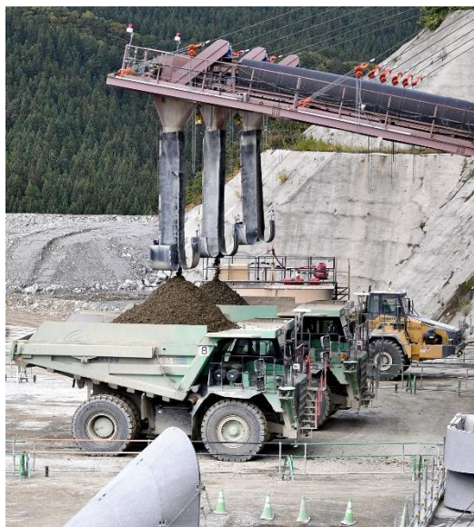
成瀬ダムの建設現場で、砂利を混ぜたセメントを積み込む無人のダンプトラック（秋田県東成瀬村で）
